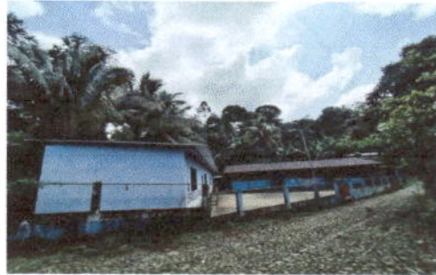
Foto 8: Pintura de muros exteriores e interiores
