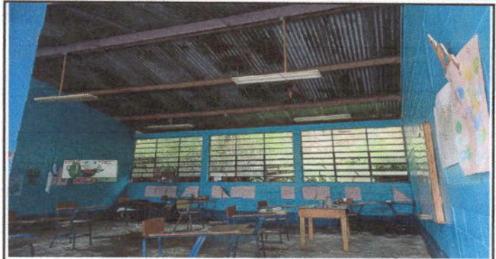
Foto 2: Mantenimiento a estructura de soporte de metal.
