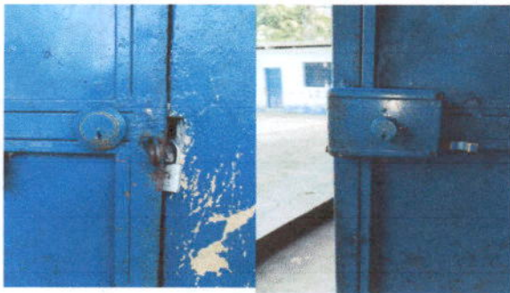
Foto 3: Sustitución de chapas
