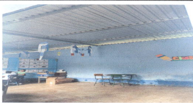
Foto 5: Reparación de Sistema electrico. Modulo 2
