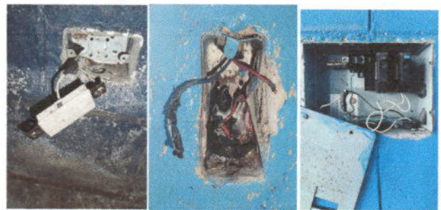
Foto 6: Reparación de Sistema electrico
