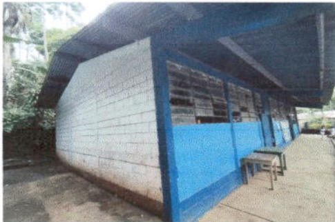
Foto 9: Pintura de muros exteriores e interiores
